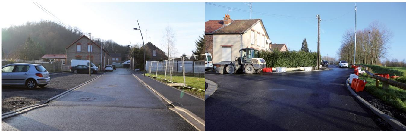
Excepté pour une partie de la rue de la Marne et pour la Cité du terril, la quasi-totalité des travaux d'assainissement sont terminés, ainsi que l'enfouissement des réseaux d'eau, de gaz, de téléphone et d'électricité. Les mâts d'éclairage public ont pour la plupart été installés. L'ensemble de la voirie a reçu une 1<sup>re</sup> couche d'enrobé, en attente de l'enrobé final.
